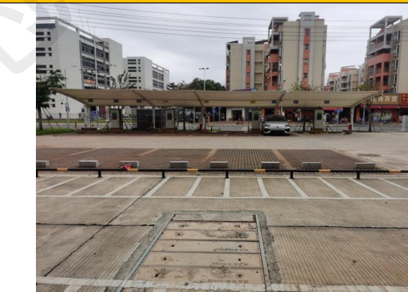
为员工配置的新能源充电桩
